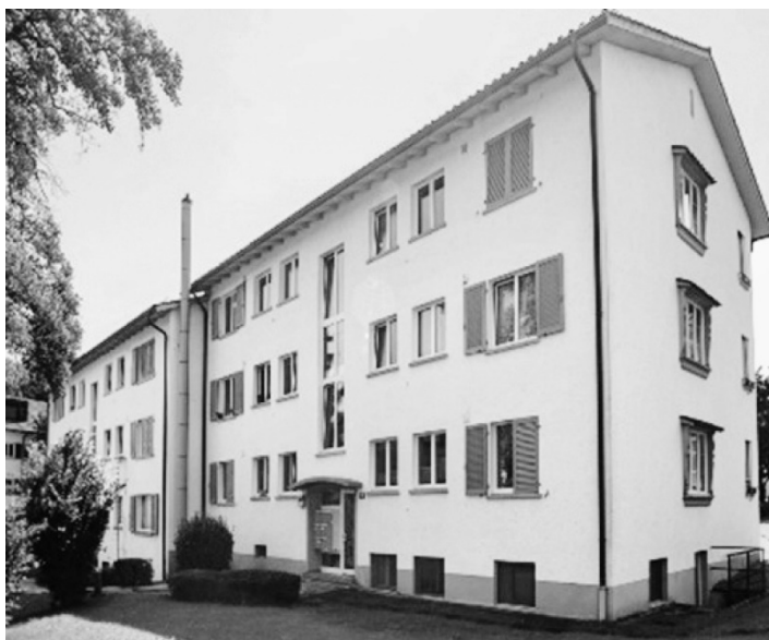
Sanierungsbedürftige Bestandsliegenschaft am Feldblumenweg in Zürich
