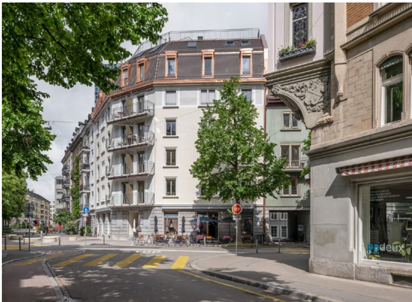
Die Repositionierung an der Hallwylstrasse in Zürich steht exemplarisch für den integralen Ansatz: Trotz anspruchsvoller innerstädtischer Rahmenbedingungen wurde die Aufstockung im Holzelementbau umgesetzt, die bestehende Substanz nachhaltig aufgewertet und zusätzlicher Wohnraum geschaffen.
