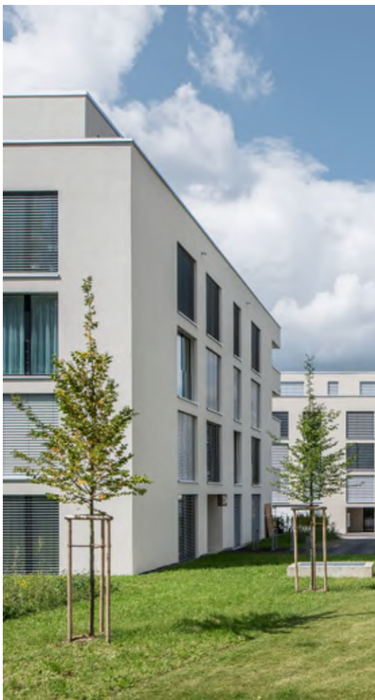
Zofingen, Riedtalstrasse 18a/18b/20a
