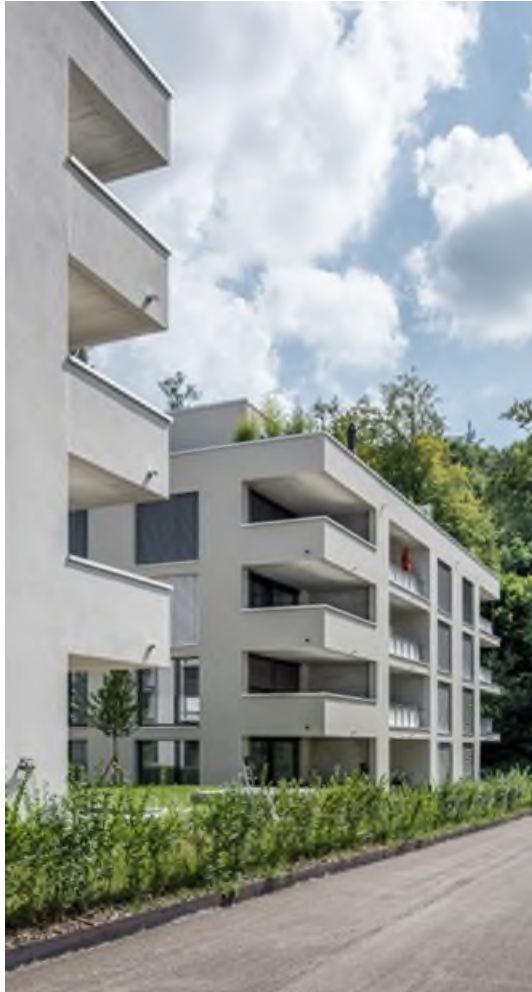
Zofingen, Riedtalstrasse 18a/18b/20a
