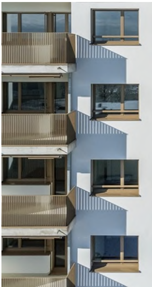
Glattbrugg, Talackerstrasse 53b
