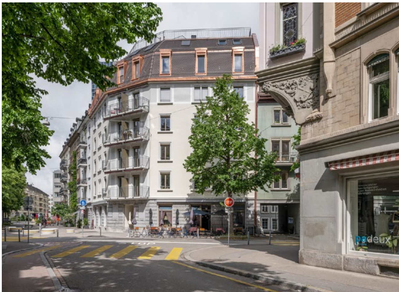
Le repositionnement de la Hallwylstrasse à Zurich illustre parfaitement cette approche globale: malgré un contexte difficile en centre-ville, la surélévation a été réalisée à l'aide d'une ossature en bois, le bâtiment existant a été réhabilité de manière durable et des logements supplémentaires ont été créés.
